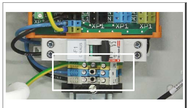
Abb. 2: Beispiel für einen Netzanschluss
